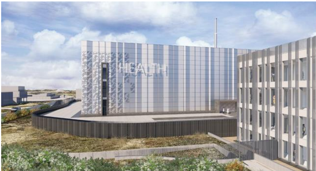
Figuur 5 De reactor met rechts een deel van het supportgebouw
