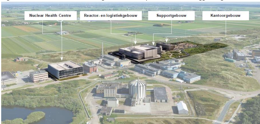
Figuur 1-2: Overzicht van de PALLAS gebouwen ten opzichte van de omliggende gebouwen
